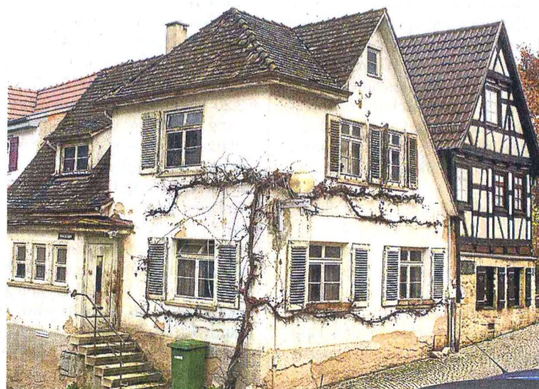
An der Stelle des maroden Breitenbücher-Hauses kommt der Museumsneubau, der direkt an das bestehende Tobias-Mayer-Museum (im Fachwerkbau) anschließt.
